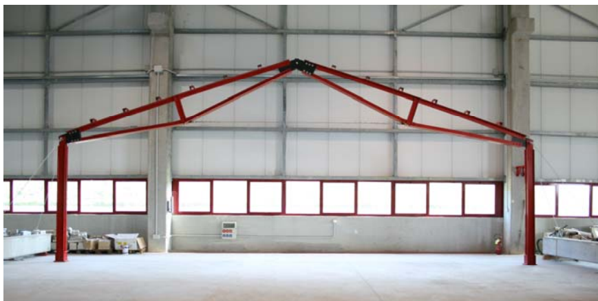
Figura 13: Fotografia della capriata da 12 metri assemblata nel Laboratorio di Ingegneria Idraulica e Strutturale del Dipartimento di Ingegneria di Ferrara.
